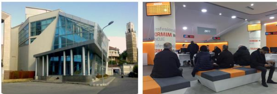
Figura 28 - Qendra e Integruar në Kavajë para dhe pas rikonstruksionit
